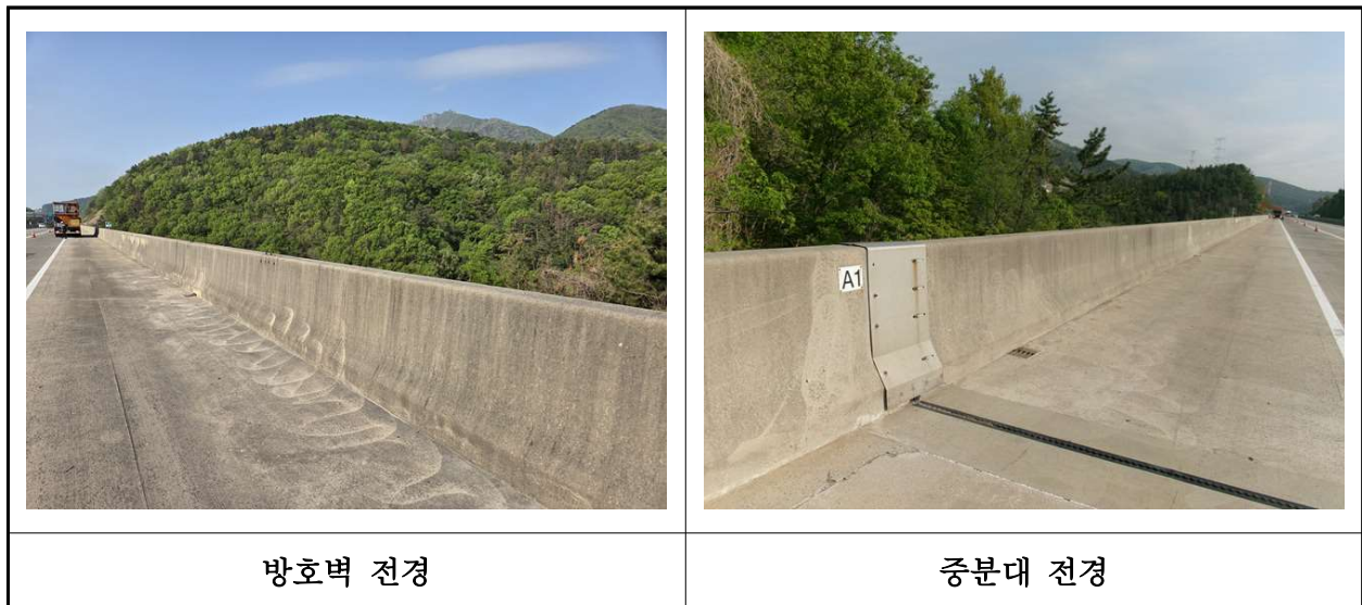
【사진 42.3.24】 방호벽 및 중분대 전경
