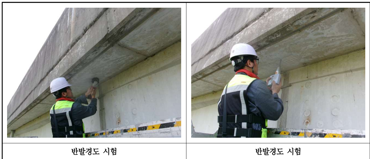
【사진 42.4.2】 반발경도시험 현장사진
