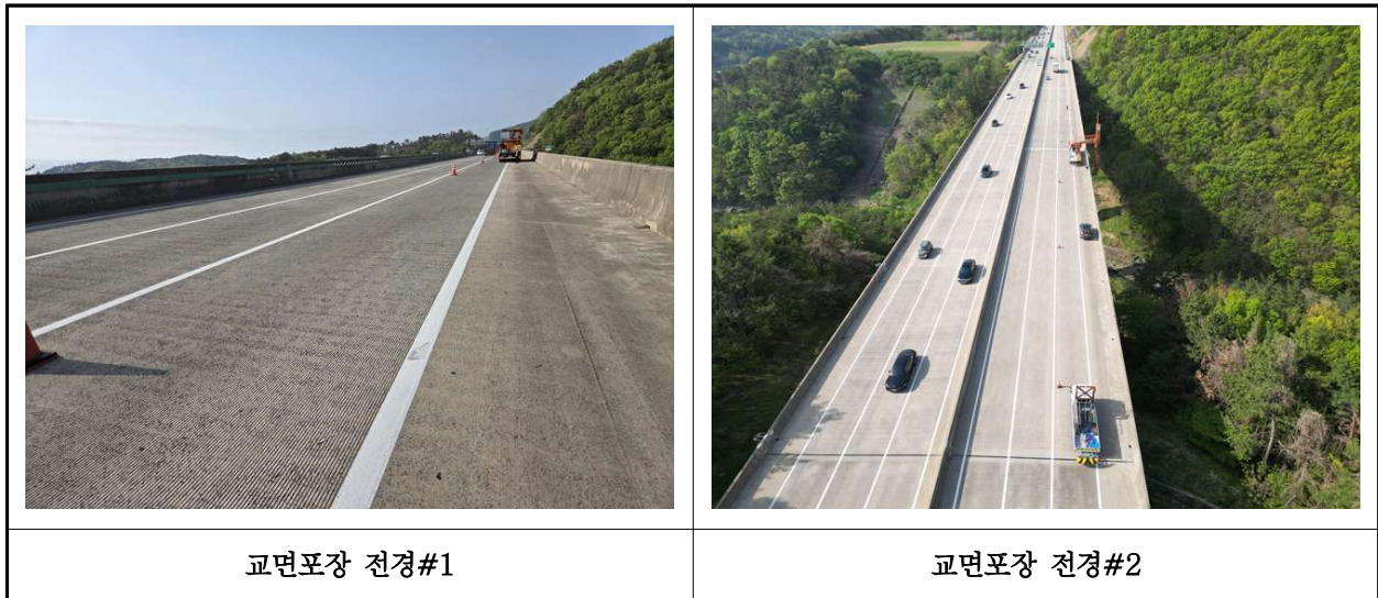
【사진 42.3.20】 교면포장 전경
