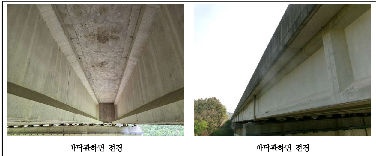
【사진 42.3.2】 바닥판하면 전경
