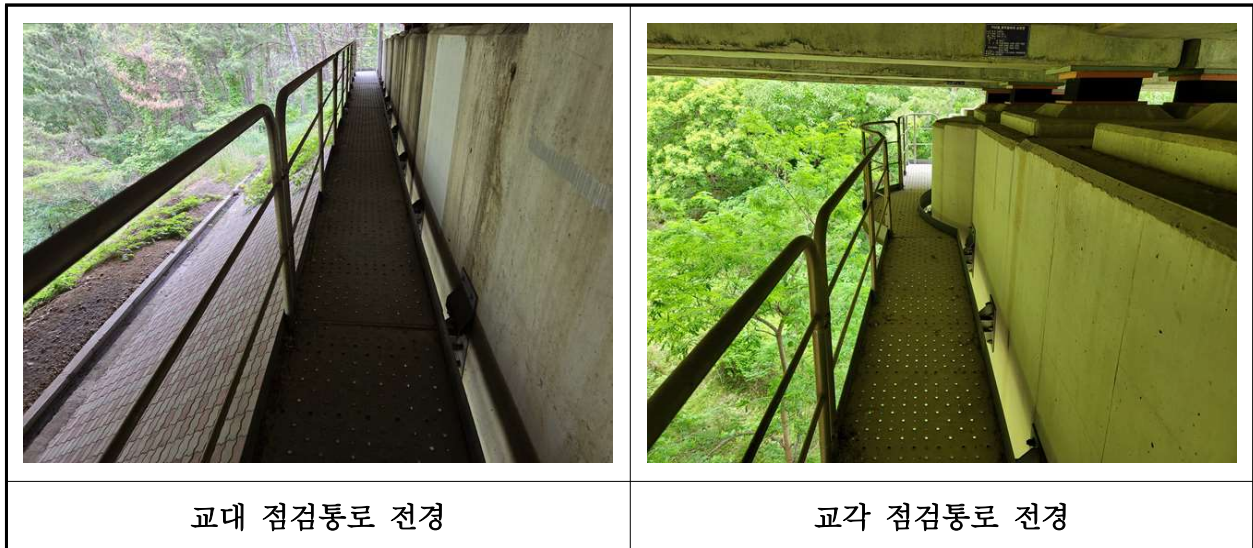
【사진 42.3.26】 교량 점검시설 전경
