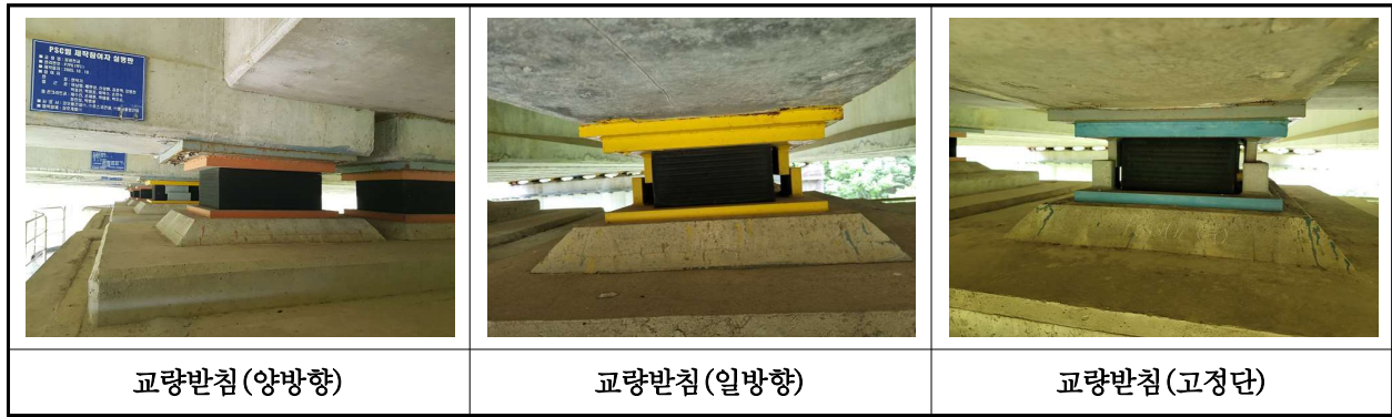
【사진 42.3.13】 교량받침 전경
